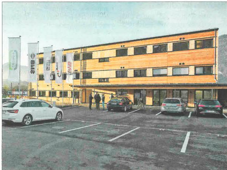
Das innovative Konzept des von der Competence Group for Clean Production entwickelten Serviceparks ist auf verschiedene Branchen anwendbar. Der Bau wurde maßgeblich von der Griffnerhaus GmbH errichtet.
